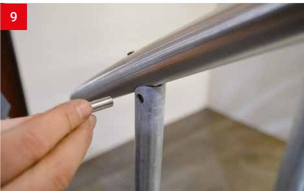
9 Klemmstab durch Pfosten und Klemmbolzen stecken.
