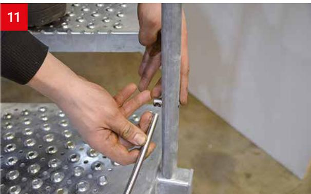
11 Zwischengurte durch Klemmbolzen führen und pofstenseitig verschrauben.
