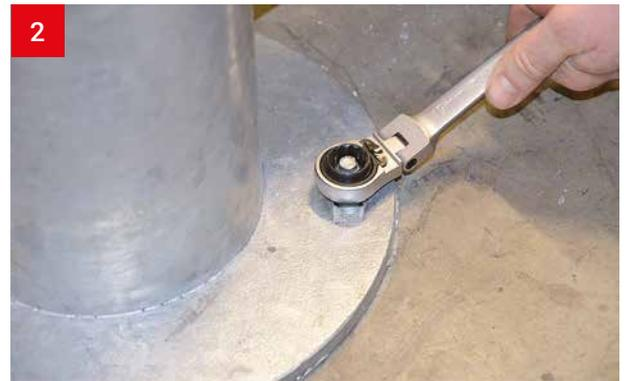
2 Säule ausrichten und mit dem Boden verankern.
