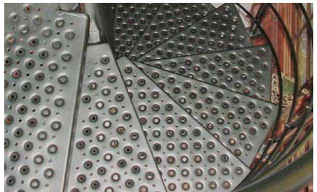
*Nach unten ausgetütete Lochblechstufen mit schwarzer Pulverbeschichtung bei Innentreppen*
