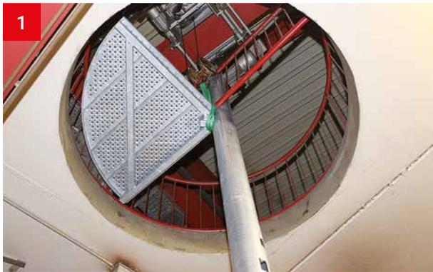
1 Podest mit Säule verschrauben (wie die Stufen) und am Deckenfutter befestigen.
