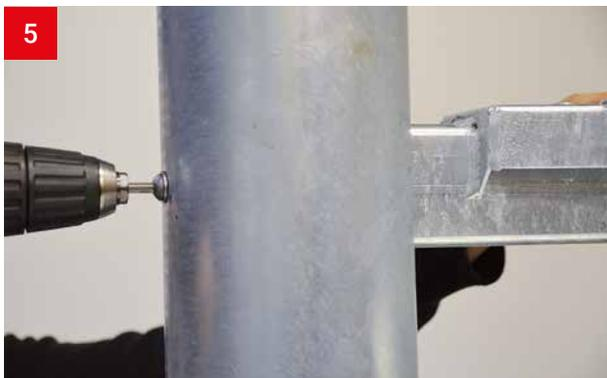
5 "Ziehschraube" entfernen und mit Montageschrauben befestigen.
