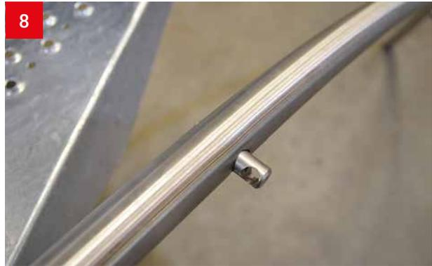
8 Klemmbolzen mit Handlauf verbinden.
