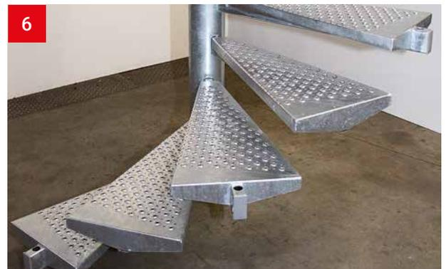
6 Stufen von unten nach oben montieren. Nach der Verschraubung ist jede Stufe sofort begehbar.
